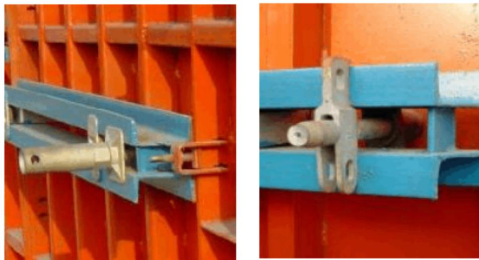
图 A.0.5.3 钢模板 对拉螺栓 端头紧固方法
