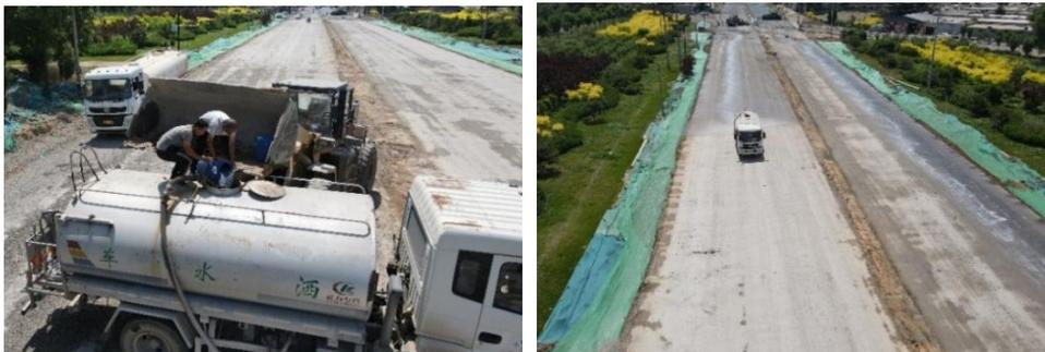
水稳碎石基层表面喷洒作业（超级油石界面微结构）
